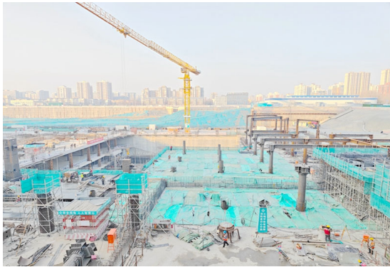
项目内施工区
