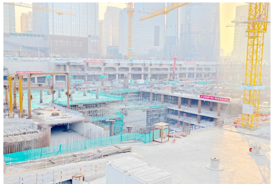
项目内施工区
