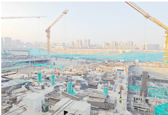
项目内施工区
