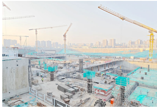
项目内施工区
